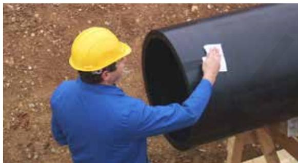
Рис. С.21: Чистка трубы (обезжиривание).
