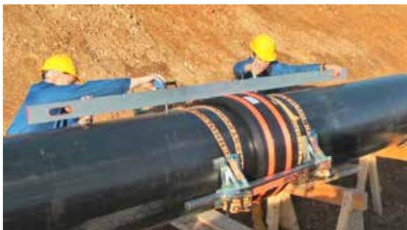
Рис. С.22: Монтаж поддерживающих зажимов и выравнивание трубы.
