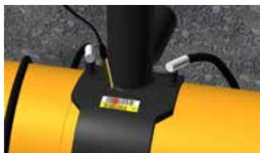
Рис. С.35: Ввод параметров сварки.
