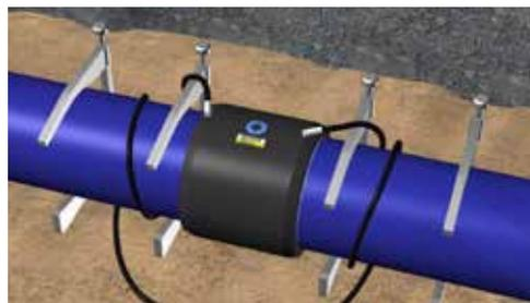
Рис. С.17: Подключение сварочных контактов.
