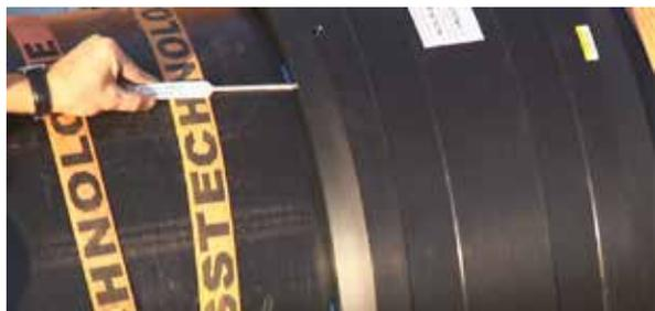
Рис. С.26: Контроль кольцевого зазора щупом.
