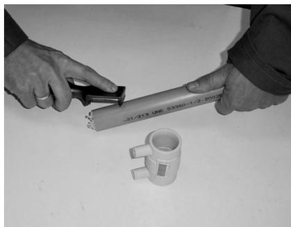
2. Наружный оксидный слой удалить с помощью цикли
