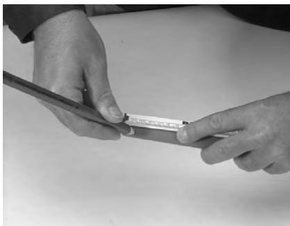
**2.** Соединяемые поверхности зачистить очистительным средством. Маркировать на трубе глубину посадки детали.
