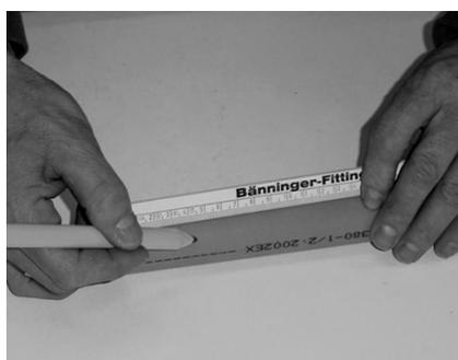
5. Отметить на трубе глубину посадки муфты
