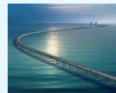
Труба НТIDC используется на мосту восточно-китайского моря
